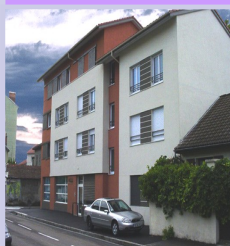
Logis de l'agglomération Grenobloise
