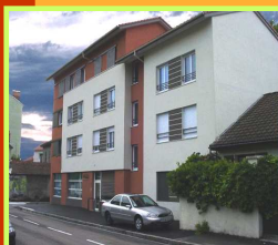
Logis de l'agglomération Grenobloise
